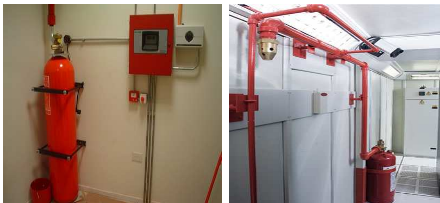
Gráfica: Sistema de extinción de incendios.
